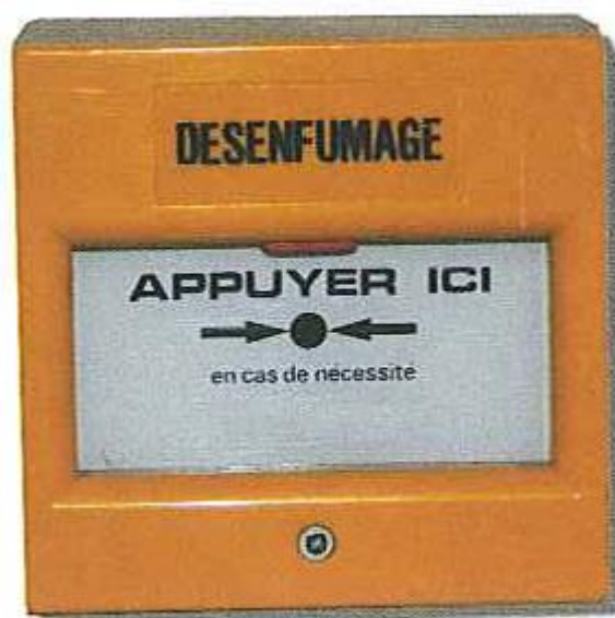
Comandament elèctric d'extracció de fum
