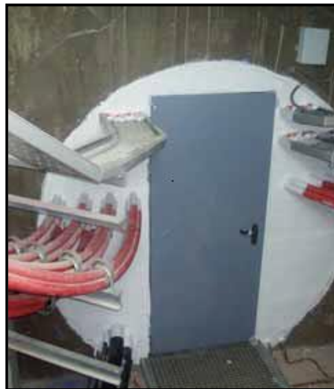
Segellat dels forats d'instal·lació elèctrica (horitzontalment) coixí intumescent, morters
