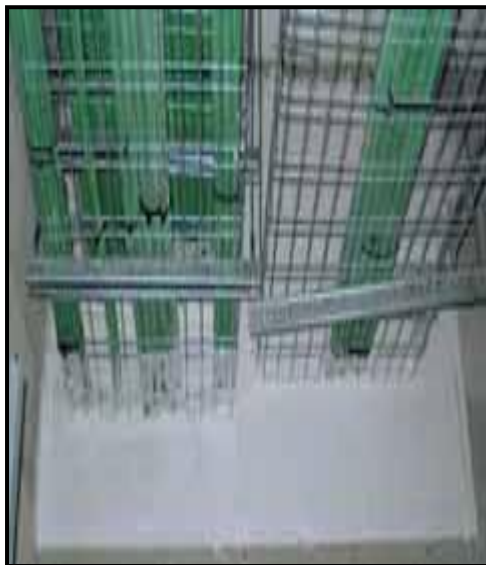
Segellat dels forats d'instal·lació elèctrica (horitzontalment) coixí intumescent, morters
