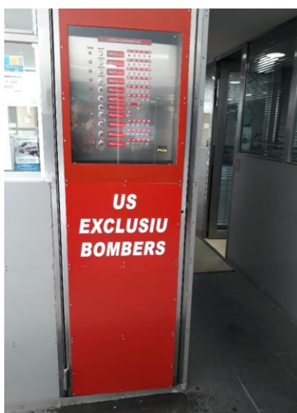
Sistema de control de fums
