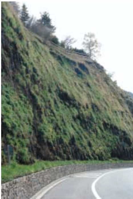
Talús revegetat amb mètodes de bioenginyeria, a la C.G. núm 2, zona del Lloser, Encamp. Foto cedida per Euroconsult SA.
