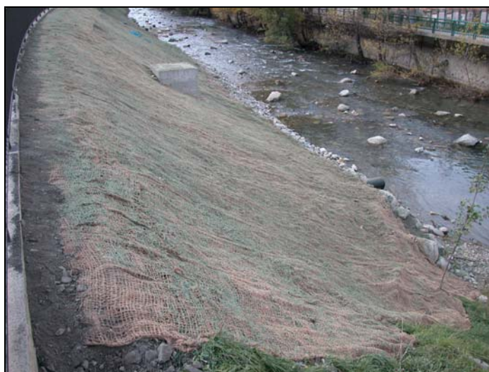
Fotografia 9.- Manta orgànica hidrosebrada al Gran Valira
