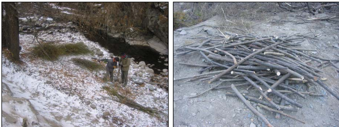
Fotografia 5.- Preparació del material per a la confecció de feixines i estaquetes de subjecció a Cal Pellissé de Canillo
