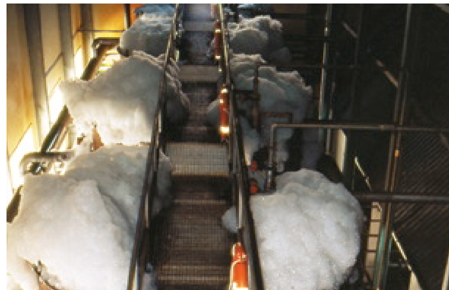
Tractament biològic per biofiltració
