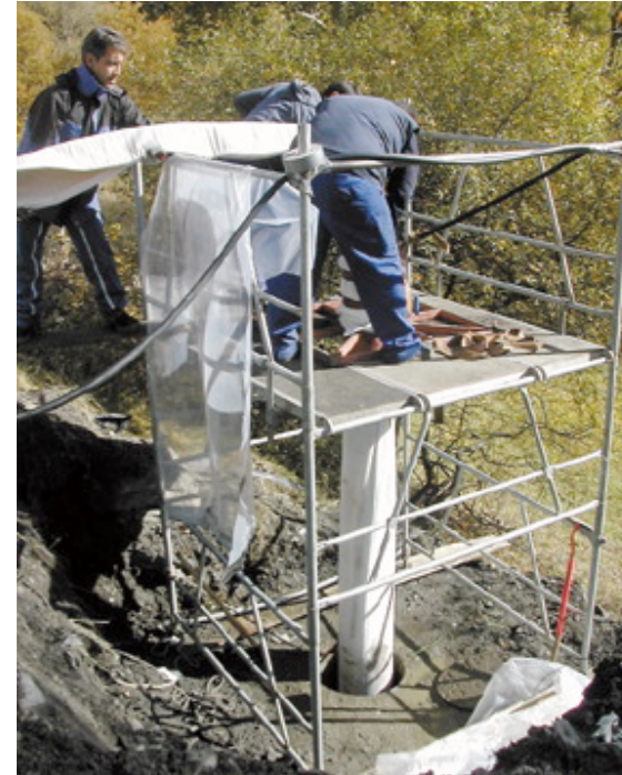
Rehabilitació d'un col·lector sense obertura de rasa
