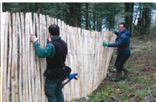
INSTAL·LACIÓ DE TANQUES DE FUSTA RÍGIDES PER LA CONTENCIÓ D'ESQUIADORS. E. MENONI, ONCFS
