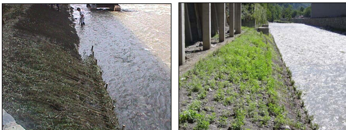
Fotografia 4.- Matalassos de branques a la riba esquerra del Gran Valira al seu pas per Sant Julià de Lòria
