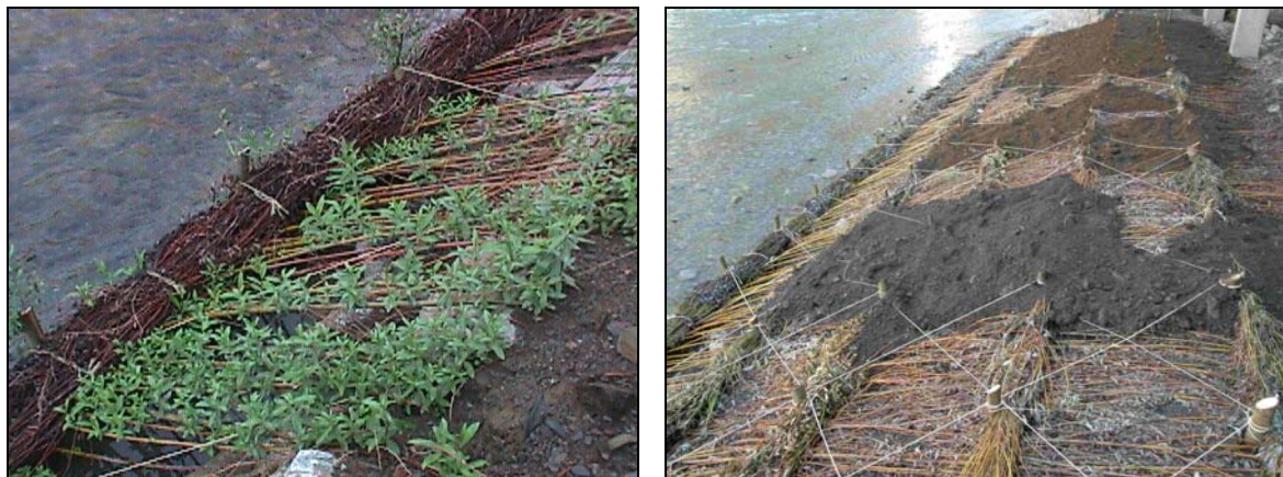
Fotografia 3.- Preparació i col·locació de matalassos de branques
