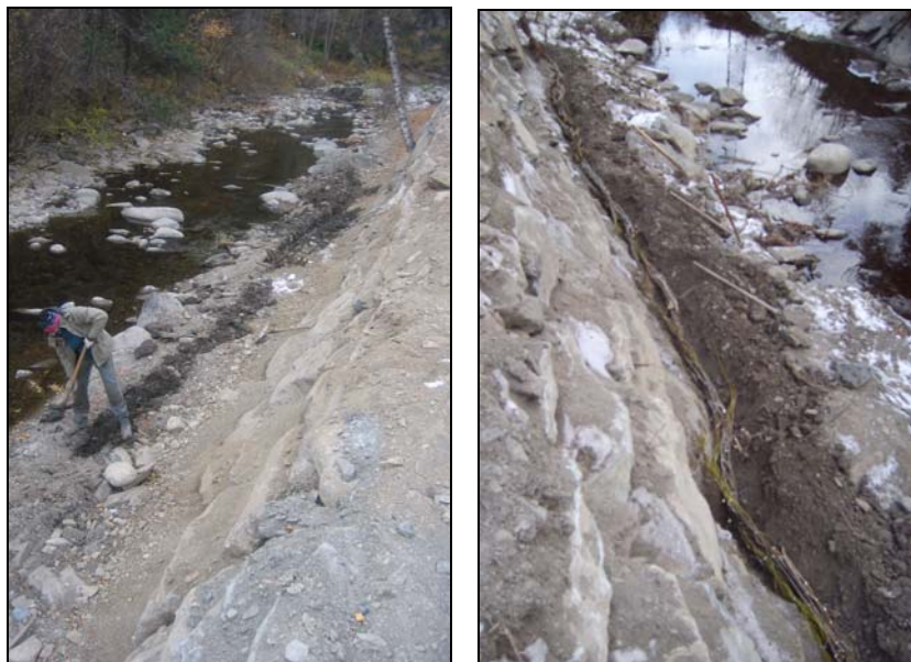
Fotografia 7.- Preparació de la rasa per a la col·locació de les feixines a Cal Pellissé de Canillo
