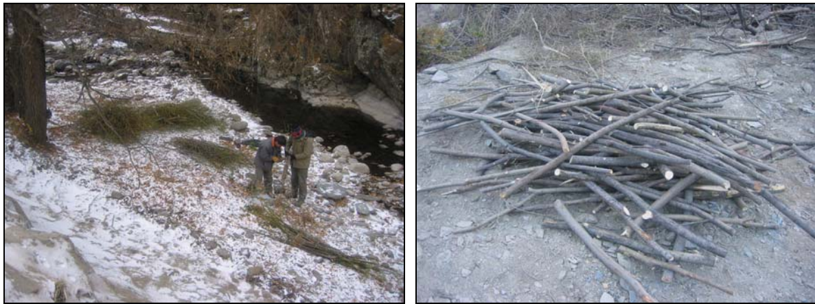
Fotografia 5.- Preparació del material per a la confecció de feixines i estacades de subjecció a Cal Pellissé de Canillo
