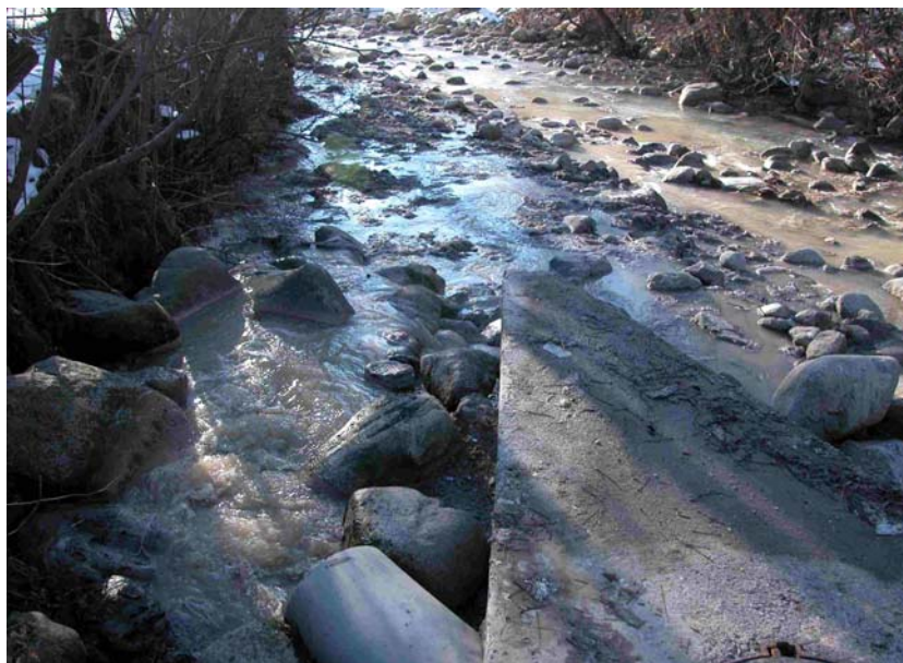
Vessament d'aigües residuals a Encamp
