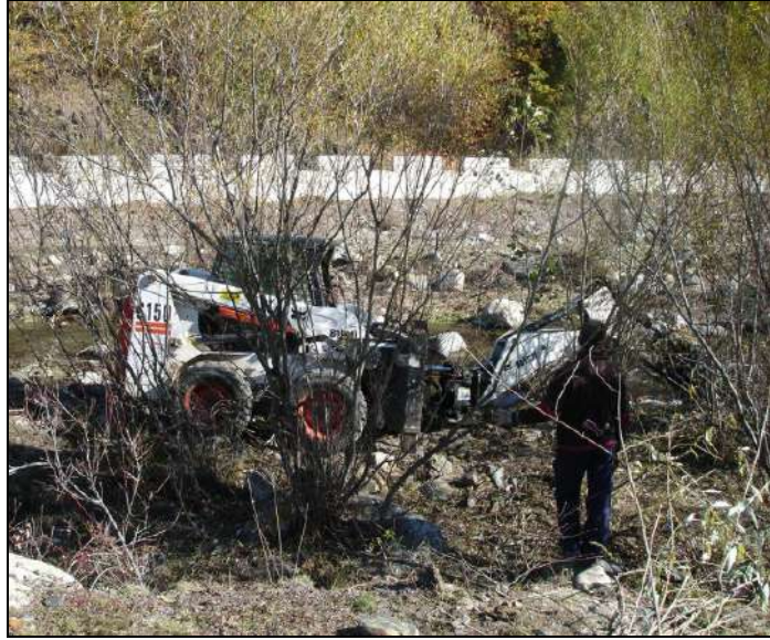
Fotografia 4.- Treball de retirada de l'espècie de la budleia mitjançant mecanització (font: Diputació de Girona i Consorci del Ter)
