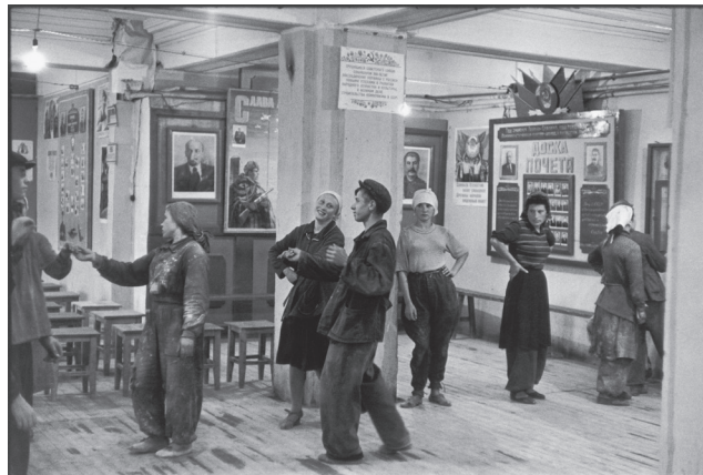
Cantina dels obrers que treballen a la construcció de l'Hotel Metropol, Moscou, 1954
