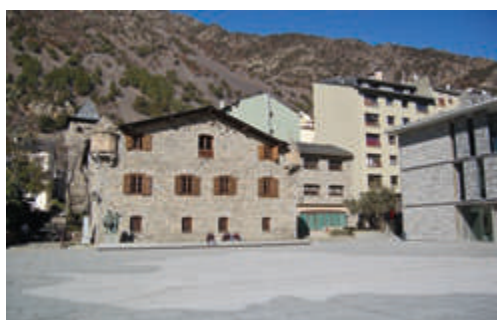
Capella de Sant Ermengol de la Casa de la Vall (Andorra la Vella)
